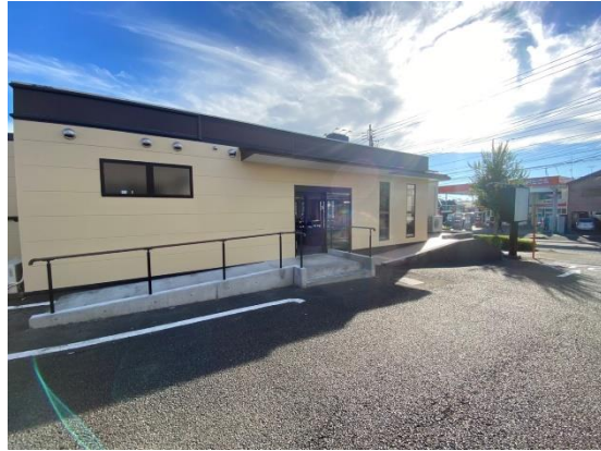
-玄関前スロープ-
