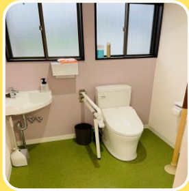
車いす用トイレ
